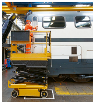
2 Changer un filtre avec une plateforme élévatrice mobile de personnel.
