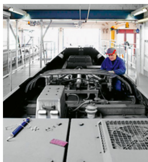
1 Travailler sur le toit du véhicule
