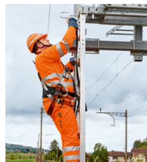
4 Escalader un mât de signalisation au moyen d'EPI antichute
