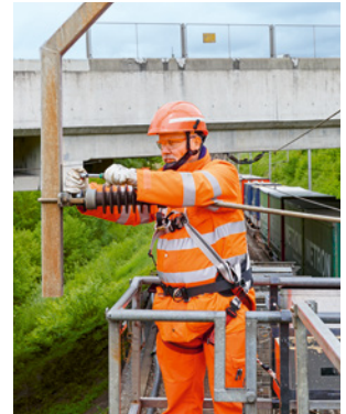
Règle 8 Prévenir les chutes.
