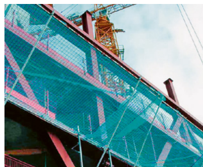
5–7 Auffangschirme werden in der Schweiz wegen der Gerüstpflicht (BauAV Art. 26) selten eingesetzt.
