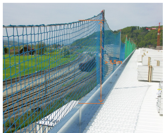
2 Auffangnetz ohne stabilen Geländerholm. Die Netz-Oberkante liegt 1,5 m über der fertig erstellten Standfläche.
