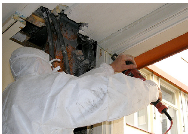
1 Taglio del telaio della finestra con una sega a gattuccio
