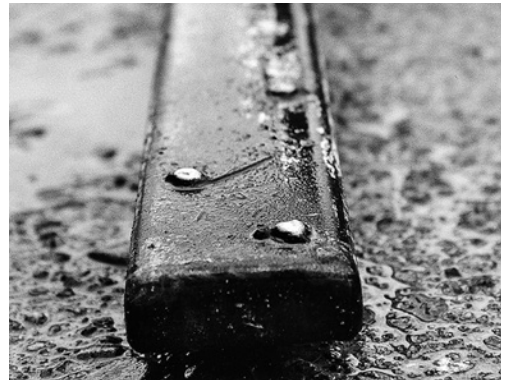
3 An dieser Gabel wurde nachträglich eine einfache, aber effektive Rutschsicherung angebracht.
