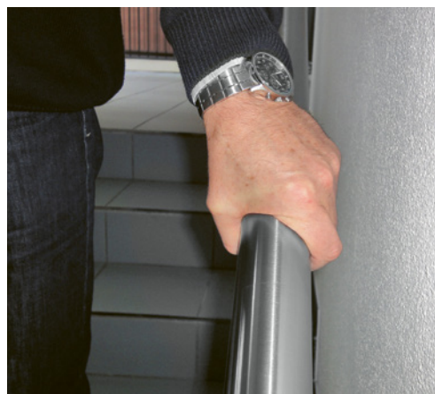
2 40 mm de diamètre pour une main courante ergonomique.
