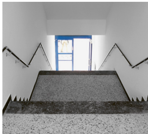
1 Contraste nécessaire pour garantir la visibilité des marches et des mains courantes.
