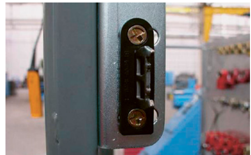
4 Missbrauch verhindern, z. B. Betätiger des Überwachungsschalters mit nicht lösbaren Schrauben befestigen (Bild), anschweissen, annieten oder Schraubenköpfe aufbohren, verkleben oder mit Stahlkügelchen verstopfen.
