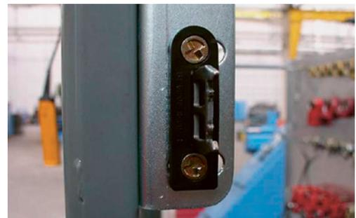
4 Missbrauch verhindern, z. B. Betätiger des Überwachungsschalters mit nicht lösbaren Schrauben befestigen (Bild), anschweissen, annieten oder Schraubköpfe aufbohren, verkleben oder mit Stahlkügelchen verstopfen.
