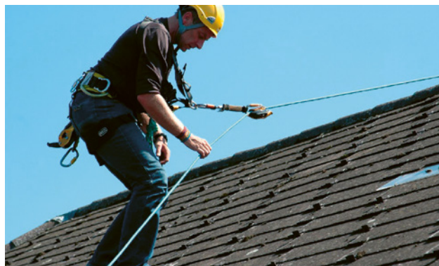
3 Bereits bei einer Zustandsaufnahme besteht Absturz- oder Durchsturzgefahr. Eine fachgerechte Sicherung ist auch hier unumgänglich!
