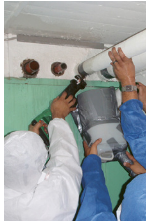
4 Schneiden eines Rohres mit der Fuchsschwanzsäge
