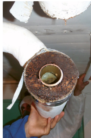
7 Abgeschnittenes Rohr, das noch mit Kunststoffolie eingepackt wird
