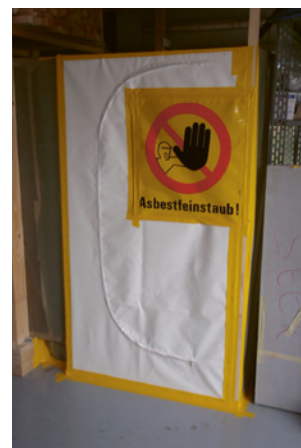
3 Dieser Arbeitsbereich ist räumlich sauber abgetrennt und gekennzeichnet.
