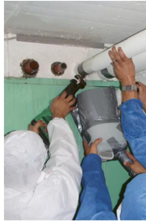
4 Schneiden eines Rohres mit der Fuchsschwanzsäge
