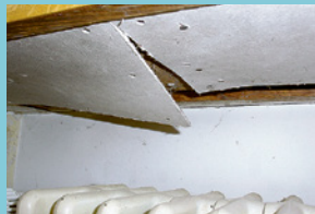
Asbesthaltige Leichtbauplatte
