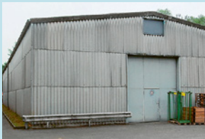
Asbesthaltige Wellplatten
