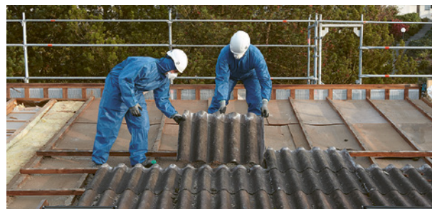
Rückbau von Wellplatten
