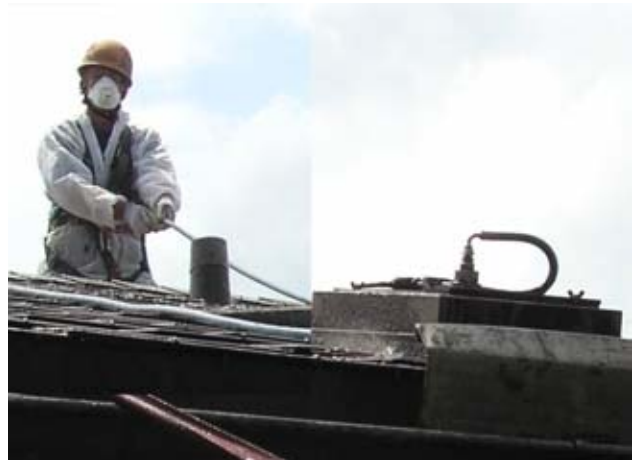
4 Asbestflächen-Reinigungssystem mit regeltem Wasserkreislauf
