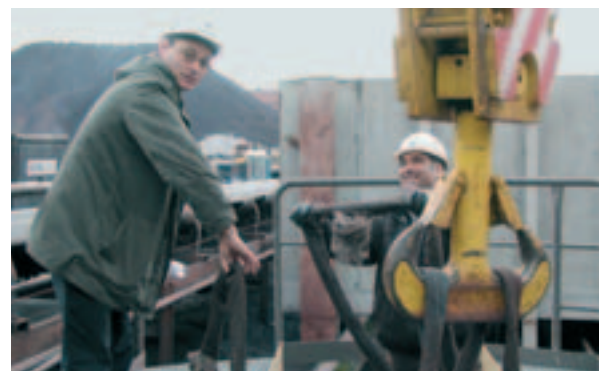
Bild 2-6: Kontrolle durch den Auftragsverantwortlichen
