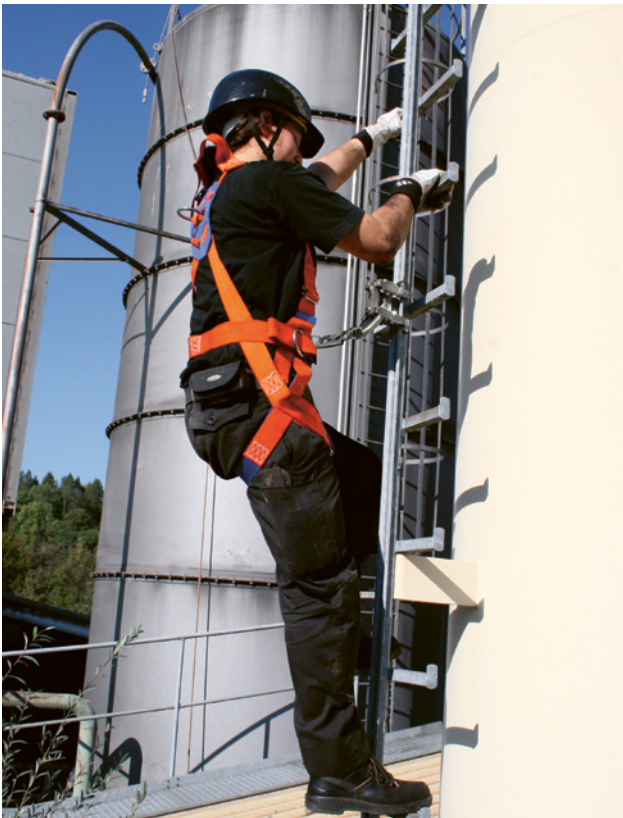
7 Absturzsicherung am Hochkamin mit ortsfester Leiter und Steigschutzeinrichtung.
