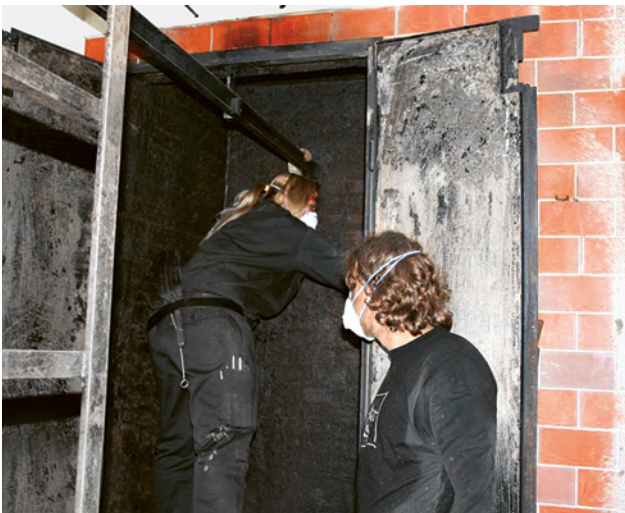
6 Personenüberwachung: Eine Person befindet sich im Feuerungsraum (Rauchkammer), die zweite Person überwacht von aussen.
