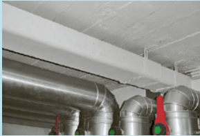
Conduites de câbles en fibrociment
