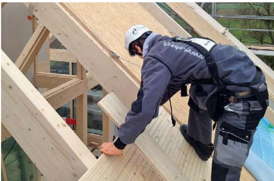
Die Schutzmassnahme für die Absturzicherung wird bereits in der Montagehalle installiert.
