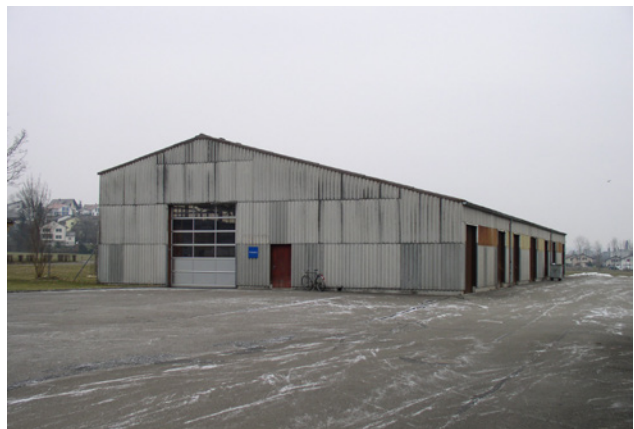
1 Capannone industriale rivestito di lastre ondulate in fibrocemento
