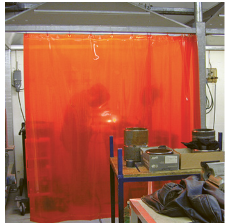
8 Zur Abschirmung benachbarter Arbeitsplätze sind z. B. brandsichere Stellwände oder Vorhänge geeignet (lichtdurchlässige Abschirmungen müssen SN EN 1598 entsprechen).
