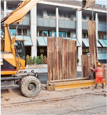
8 Sicherer Einbau von Spriessen.
