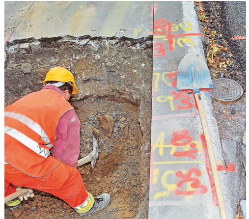
1 Werkleitungen bei Bedarf sondieren.
