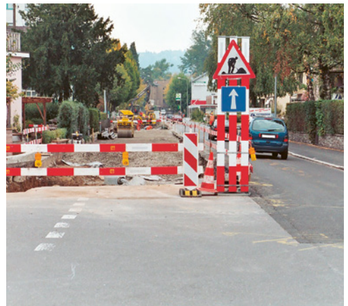
2 Korrekt signalisierte Baustelle.
