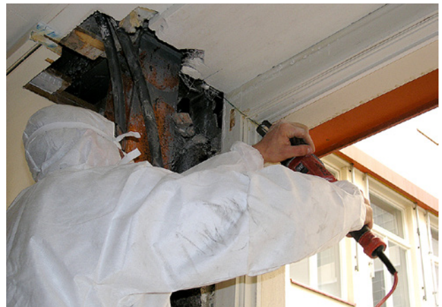
1 Aufschneiden des Fensterrahmens mit einer Fuchsschwanzsäge
