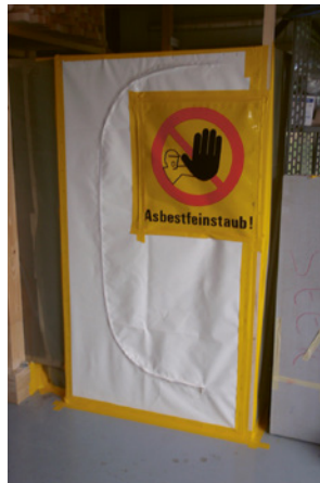
5 Sauber abgetrennter Arbeitsbereich
