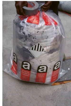
6 Kunststoffsack mit der Kennzeichnung Asbest
