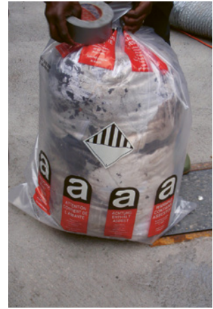
6 Kunststoffsack mit der Kennzeichnung Asbest
