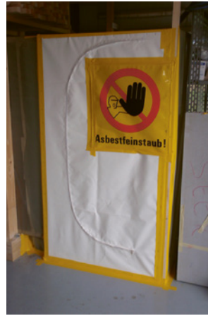
5 Sauber abgetrennter Arbeitsbereich
