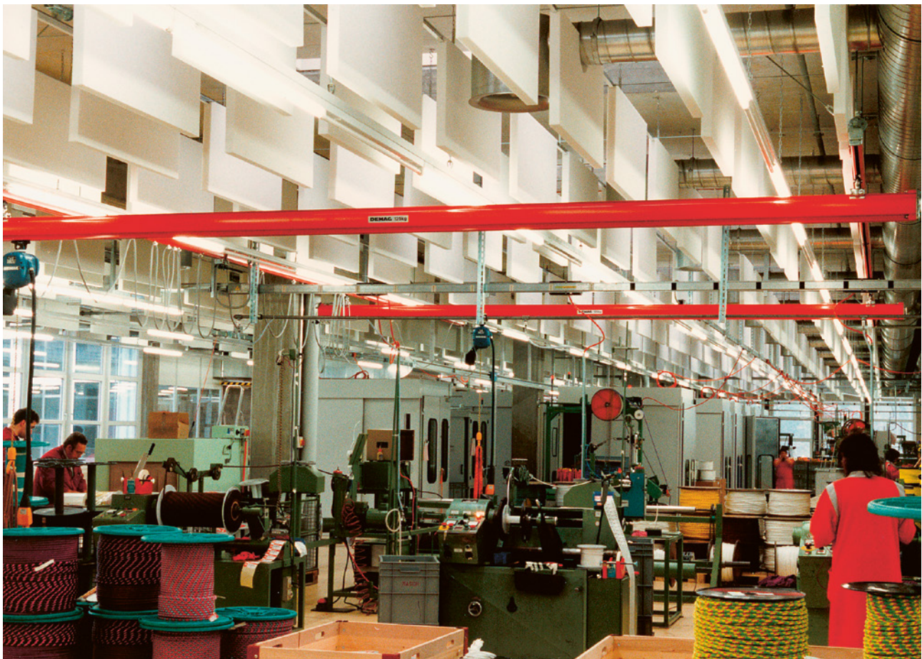
33 Fabrikation mit Baffeln an der Decke.
