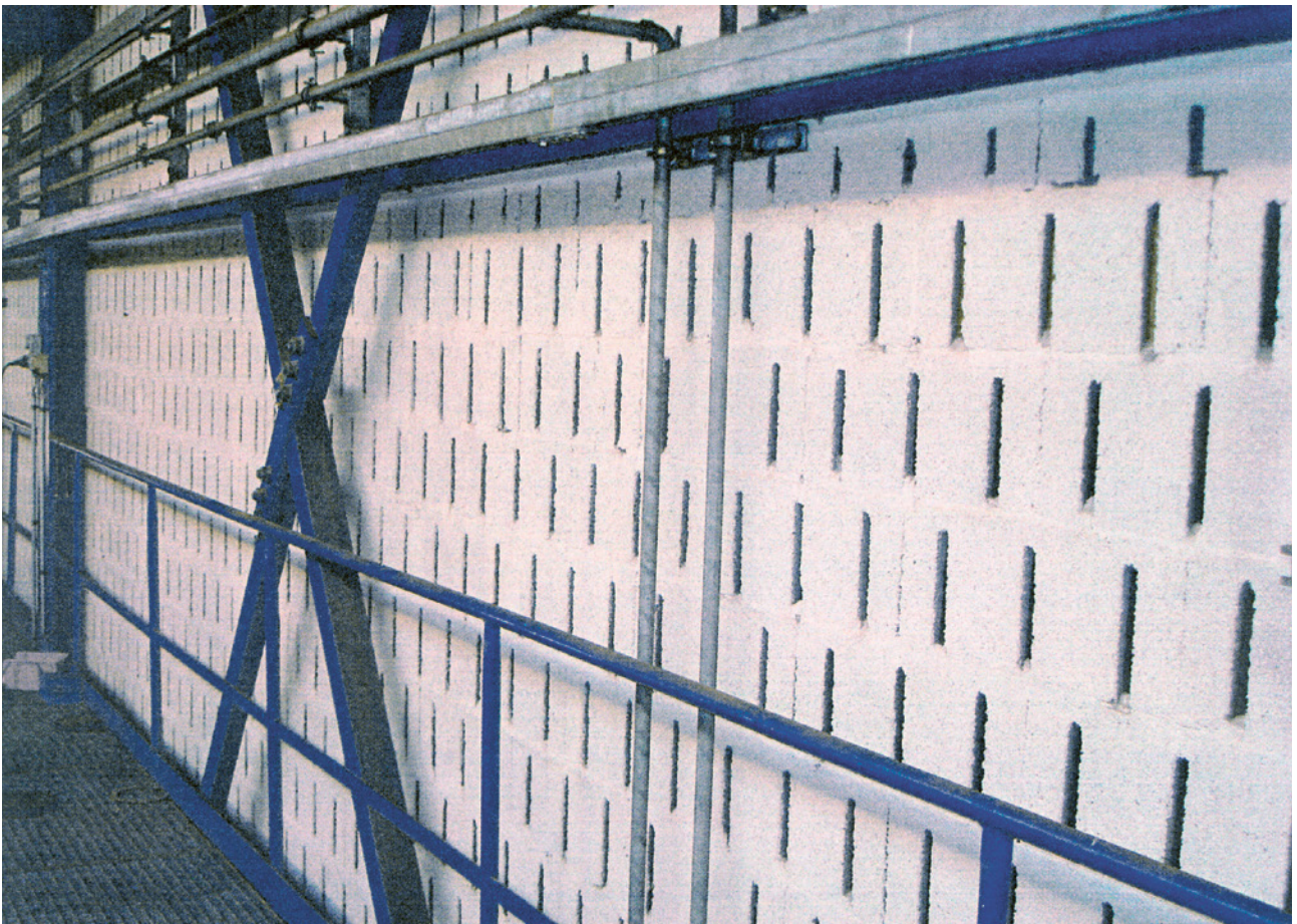
19 Geschlitzte Spezialsteine mit Hohlräumen und Dämpfungseinlagen in einer Schlosserei.
