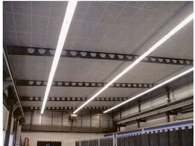
15 Beschichtete Steinwolle-Akustikplatten in einer Spenglerei.
