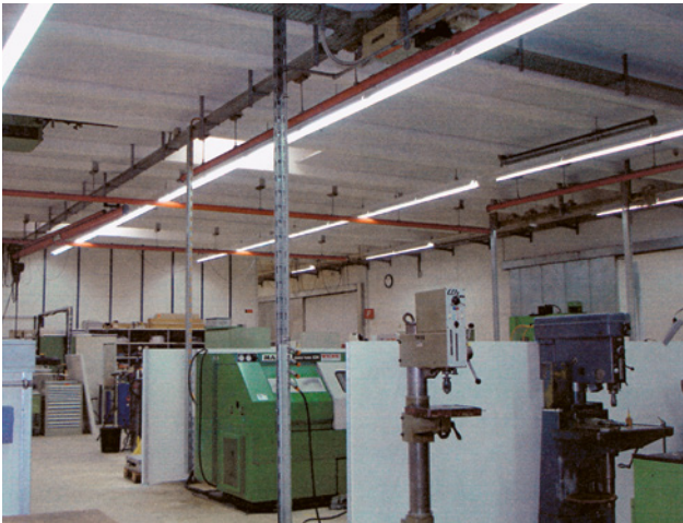
14 Mineralfaser-Akustikplatten in einem mechanischen Betrieb.
