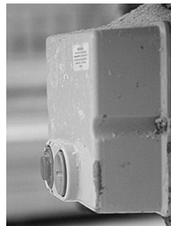
1 Esempi di sistemi di sicurezza contro l'avviamento accidentale: cornici o bordi sporgenti, interruttori con pulsante incassato.
