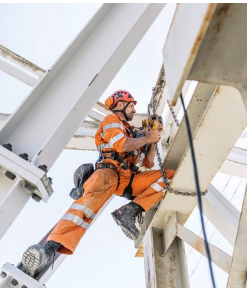
In arrampicata: alcuni bulloni sono difficili da raggiungere.
