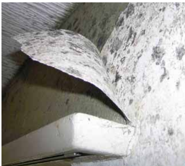
Figura 2: muffa sulla tappezzeria e sullo strato di intonaco sottostante (la muffa ha intaccato gli strati più profondi).
