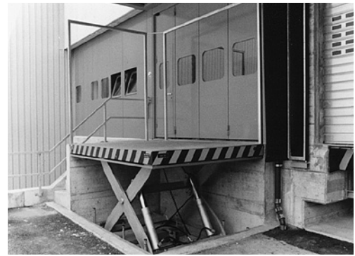
1 Beim Absenken der Hebebühne bewegt sich auch das Geländer nach unten und bildet eine Abschränkung für die oberen Zugänge.
