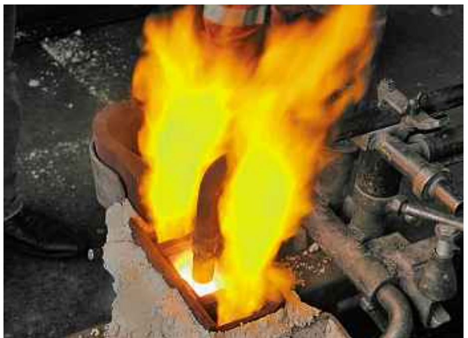
Bild 1: Schweißen von Eisenbahnschienen mit dem Thermitschweisverfahren
