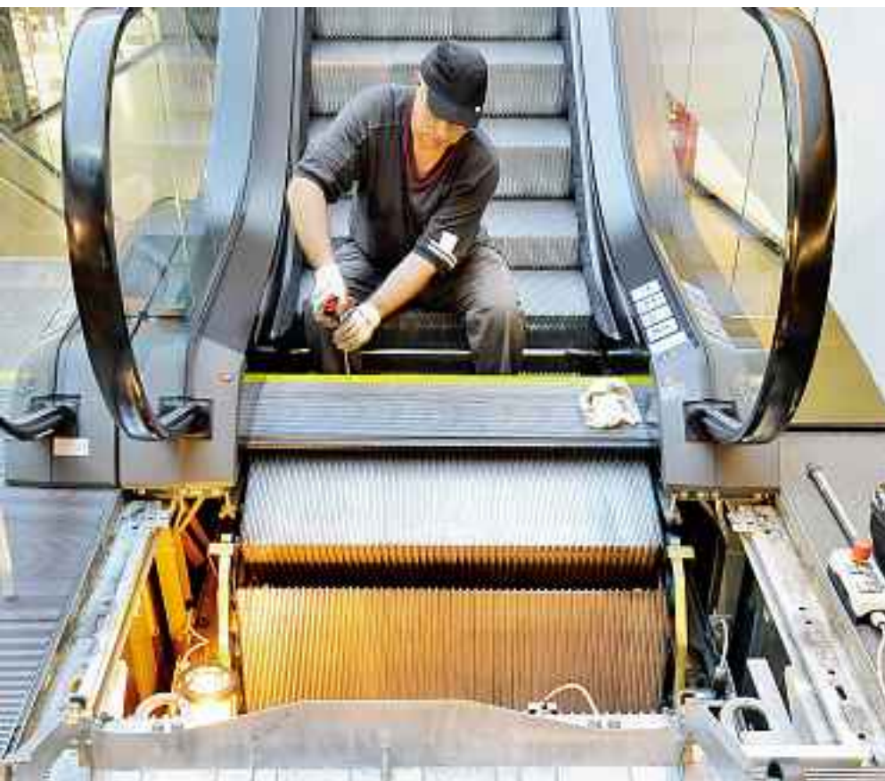
Rolltreppe vor unerwartetem Anlaufen sichern, Bereich absperren sowie Schutzhandschuhe und Schutzschuhe tragen.
