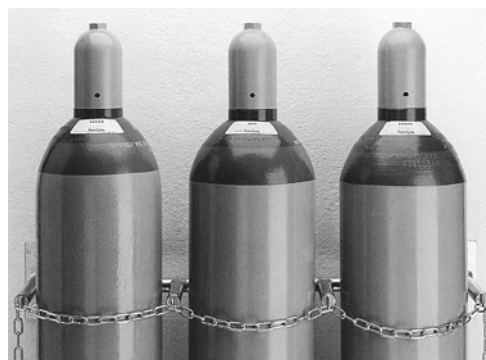
3 Bombole di gas tenute ferme da catene
