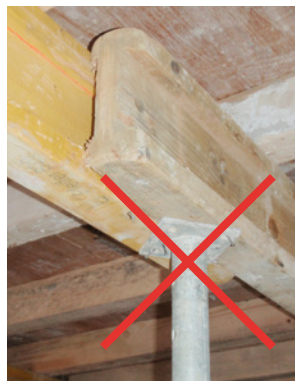
1, 2 Unzulässiger Jochträger-Stoss (links): mangelhafte Stabilität wegen exzentrischer Krafteinleitung. Erforderlich ist ein Vierwegkopf (Gabelkopf, siehe Bild rechts).
