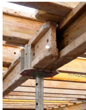
1, 2 Unzulässiger Jochträger-Stoss (links): mangelhafte Stabilität wegen exzentrischer Krafteinleitung. Erforderlich ist ein Vierwegkopf (Gabelkopf, siehe Bild rechts).
