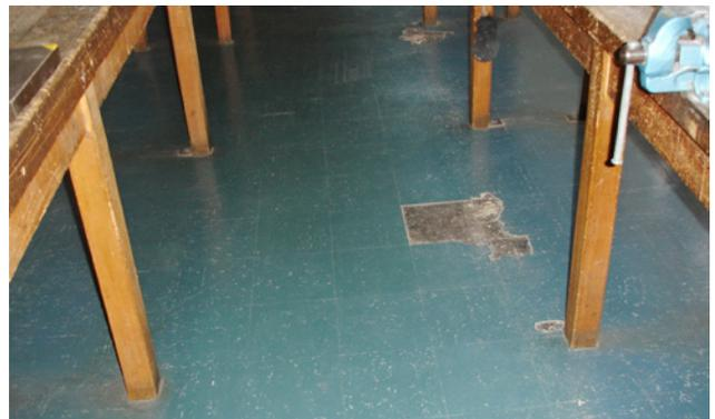
1 Einschichtige sogenannte Floor-Flex-Beläge. Hier ist der Asbest in der Matrix festgebunden.
