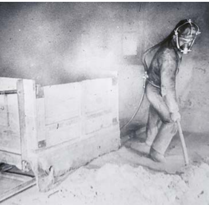
2 sableur équipé d'un casque à adduction d'air frais de la Suva en train de pelleter du sable
