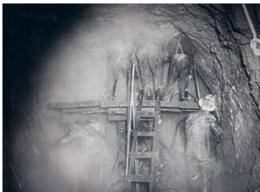
1 perçement de galeries par forage à sec
