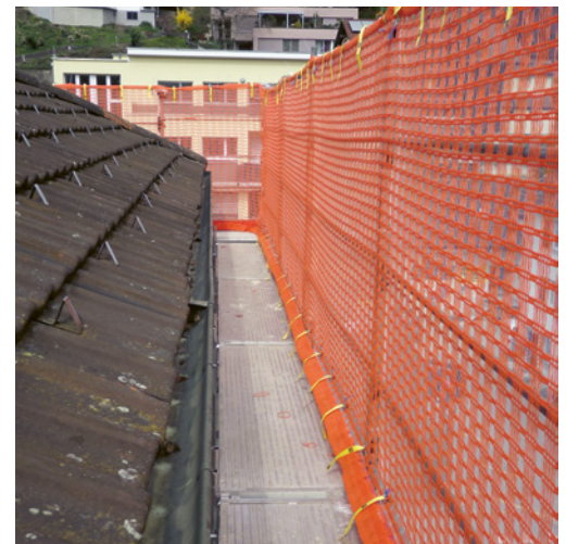
5 Bei Dächern mit einer Neigung von 30° und mehr bietet eine nach SN EN 13374 geprüfte Dachdeckerschutzwand einen idealen Schutz gegen Abstürze von Personen.
