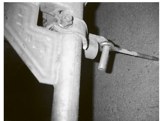
2 Zug- und druckfeste Verankerung, bestehend aus Bohrdübel und Ringschraube von genügender Tragfähigkeit.
