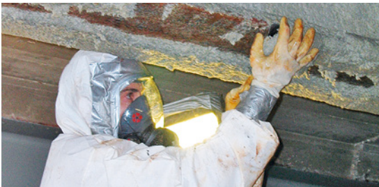
Asbestsanierung
