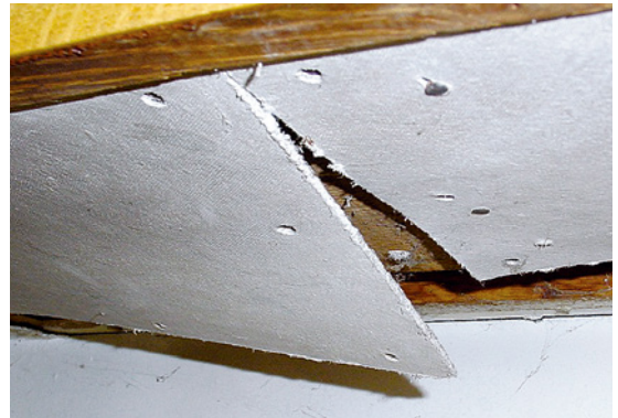
Asbesthaltige Leichtbauplatten
