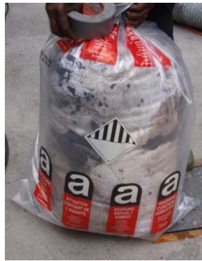
2 Déchets contenant de l'amiante faiblement aggloméré emballés dans des sacs en plastique indéchirables hermétiques à la poussière.
