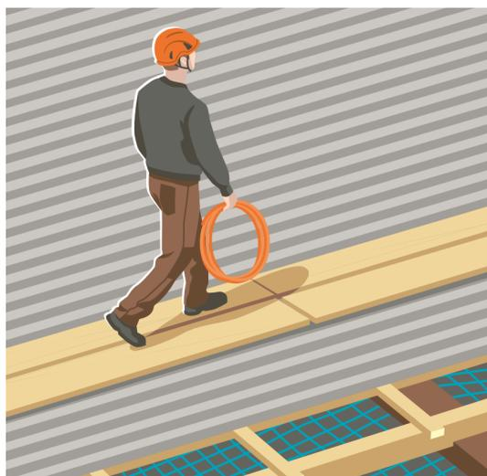
**Regola 5:** lavoriamo solo su superfici di copertura resistenti alla rottura.
